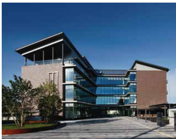
安来庁舎建設工事
