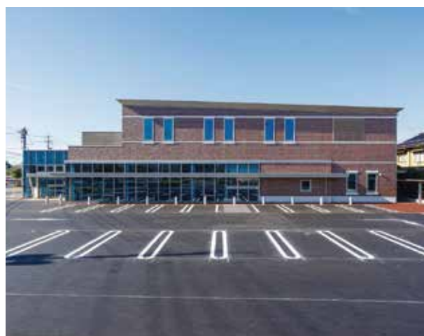
山陰合同銀行安来支店新築工事
