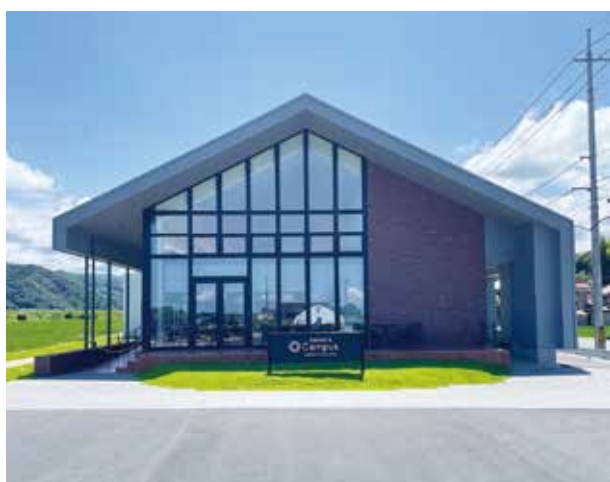
櫻苑 製菓・製パン工場、販売店舗、喫茶室新築工事
