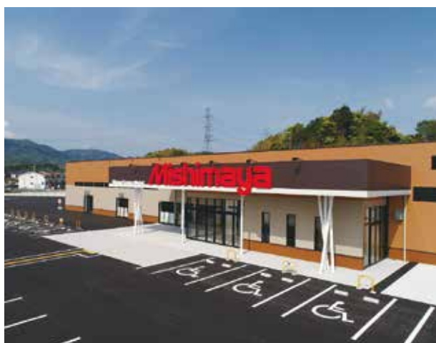
みしまや東川津店新築工事
